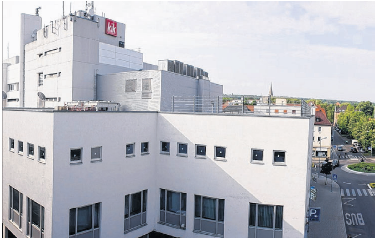
Das Frey-Center in der Bleichstraße soll abgerissen werden. Wann die Bagger anrücken, ist jedoch noch völlig offen. Die Stadtverwaltung liebäugelt mit einem Bebauungsplanverfahren. Das könnte dauern. Foto: Archiv / Giacinto Carlucci
