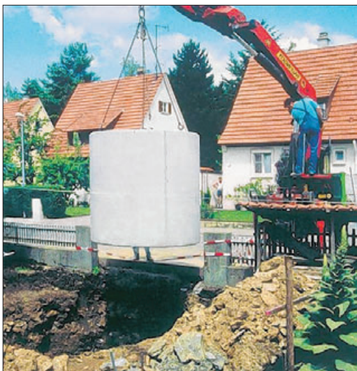
Der Einbau von Zisternen schont Ressourcen, die Wirkung auf die Abwassergebühr ist aber umstritten.
