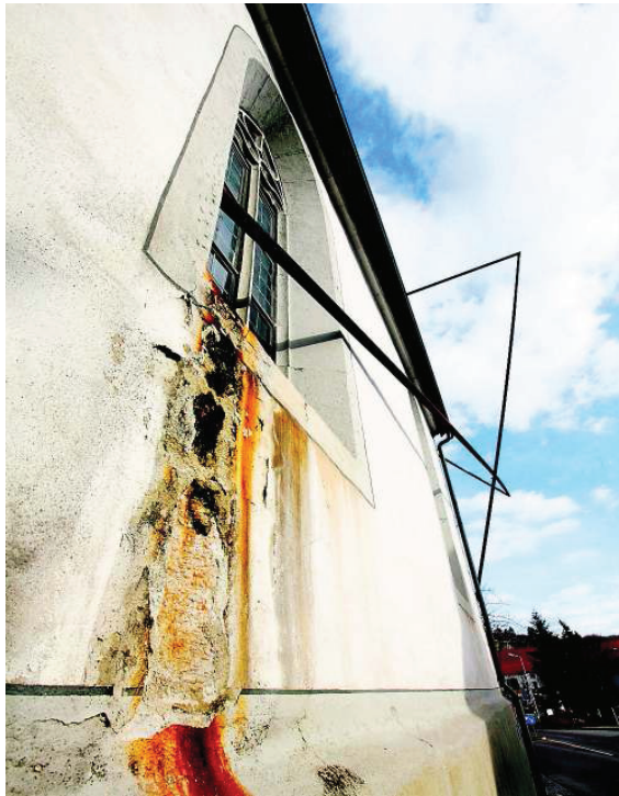
Die Wand des Jüdischen Museums wird saniert, der Rost kommt weg.
