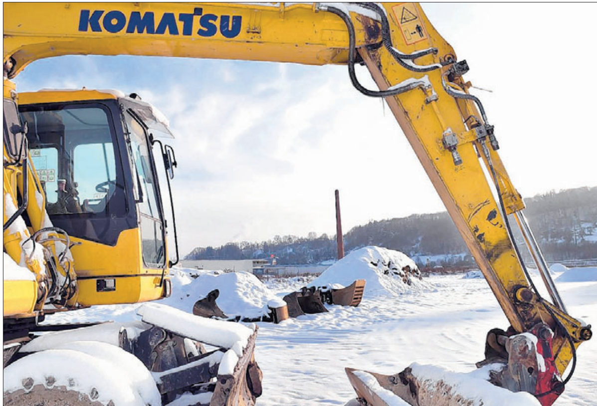
Die Bauarbeiten für eine gute Verkehrsanbindung des Weberareals laufen längst: Im kommenden Jahr soll das Gelände neu bebaut werden. Die Stadt hat dazu einen Vertrag mit der Firma Rieger geschlossen. Foto: Giacinto Carlucci
