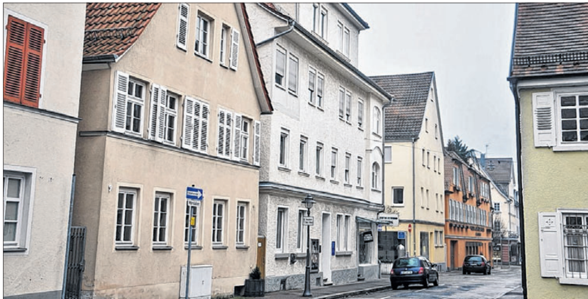
Bild oben: Das Gebäude der Drogerie Rossmann und das Haus Scherfig im Apostelquartier gehören nun der Wohnbau.
